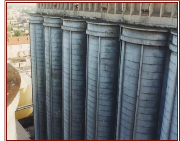
Silosy w Kruszwicy
